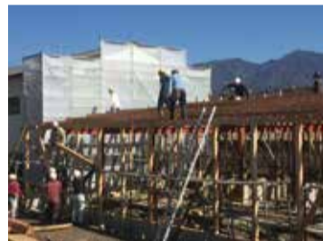
堆肥舎の増築
