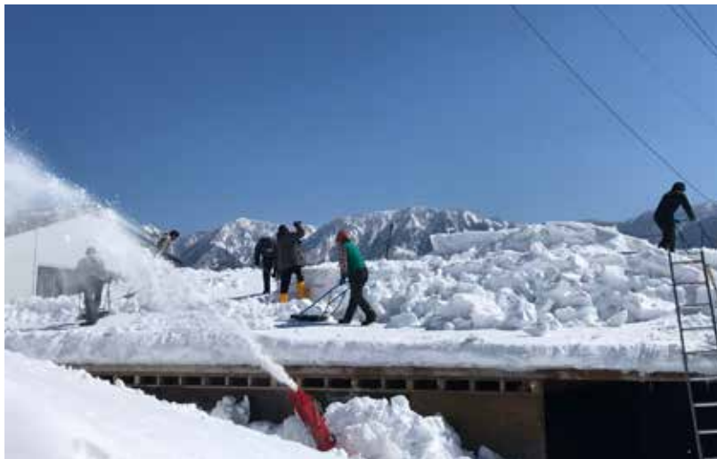
堆肥舎の屋根に上がり、皆で除雪。信州立屋共働学舎 (3月4日)
